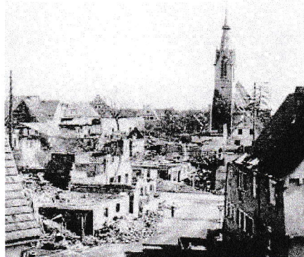
Echterdingen nach der Zerstörung am 15. März 1944.
